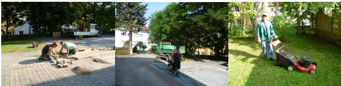
Arbeiten in der Bergstraße
