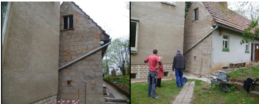
Vom herunterfallenden Putz, befreite Giebelwand am Nebengebäude
