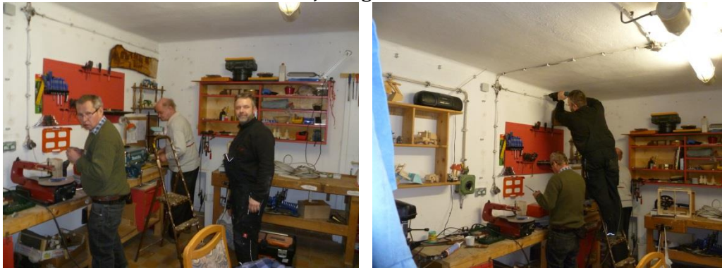
Erneuerung von Stromkabel
